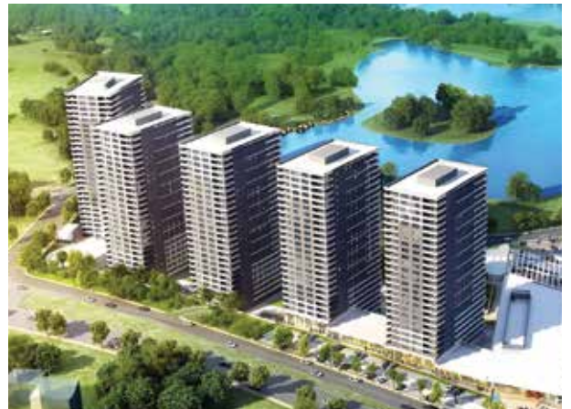
Proje İsmi : Kaşmir Mavi Orkide Evleri Şehir : Ankara Yatırımcı : Gülsan Holding, Köroğlu İnşaat ve MNT İnşaat İş Ortaklığı Tarih : 2019
