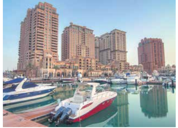
Proje İsmi : Porto Arabia Apartments Şehir : Doha, Katar Yatırımcı : United Development Company Tarih : 2015
