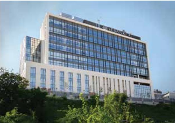
Proje İsmi : İstanbul Finans Merkezi İlbank Binası Şehir : İstanbul Yatırımcı : İlbank A.Ş. Tarih : 2023
