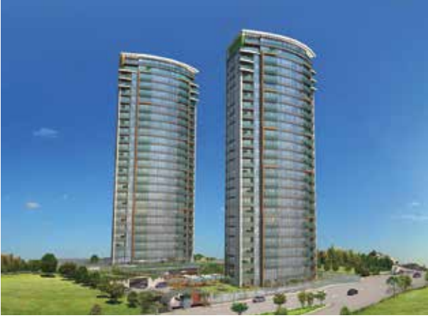
Proje İsmi : Gökdeniz Kartal Şehir : İstanbul Yatırımcı : Gülsa İnşaat, Bay Yapı Tarih : 2016
