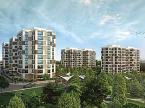
Proje İsmi : Sancaktepe Adres Kuru Şehir : İstanbul Yatırımcı : Bayraktar İnşaat Tarih : 2017
