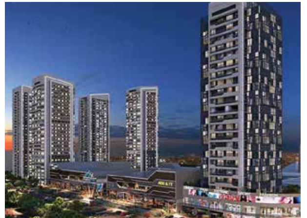
Proje İsmi : MetroMall Şehir : Ankara Yatırımcı : Söğüt İnşaat Tarih : 2016
