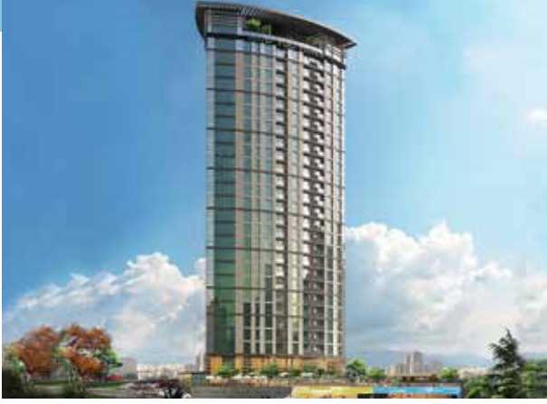
Proje İsmi : NND 100 Tower Şehir : İstanbul Yatırımcı : Nanda Yapı Tarih : 2016
