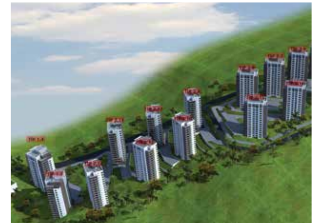
Proje İsmi : TOKİ Gölbaşı İncek Konutları Şehir : Ankara Yatırımcı : YDA İnşaat ve Yüksel İnşaat Konsorsiyumu Tarih : 2016
