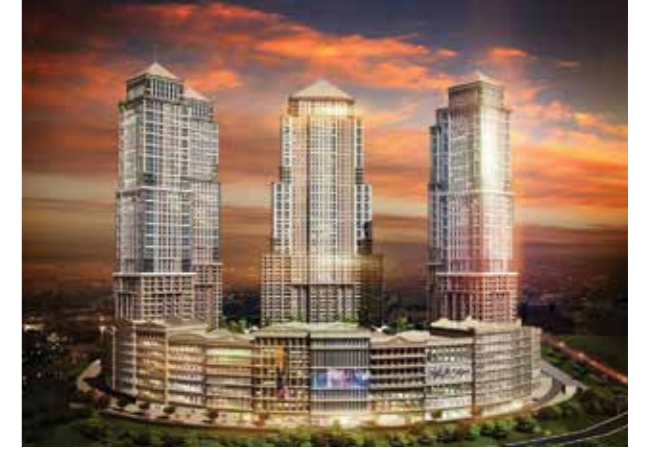
Proje İsmi : Viaport Venezia Şehir : İstanbul Yatırımcı : Bayraktar İnşaat, Gür Yapı Tarih : 2015
