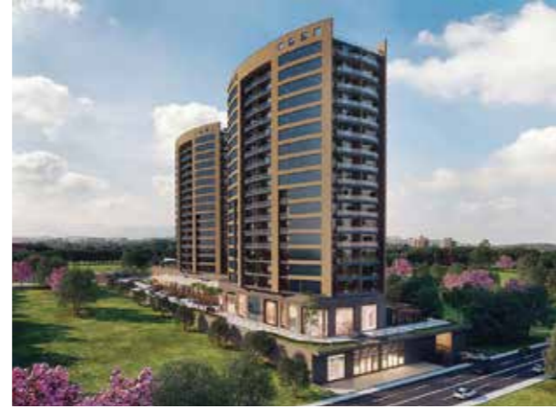
Proje İsmi : Ataköy Towers Şehir : İstanbul Yatırımcı : Aziz Yapı Tarih : 2016
