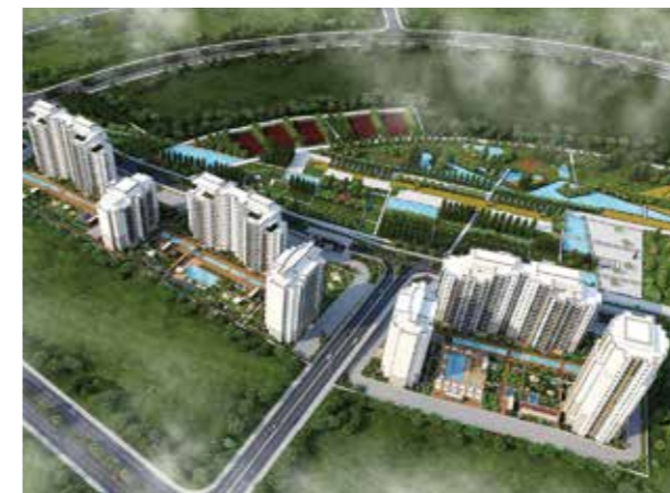
Proje İsmi : Bahçekent Flora Şehir : İstanbul Yatırımcı : Emlak Konut GYO, Toki, İzka İnşaat, Dağ Mühendislik ve Sitar İnşaat Tarih : 2016
