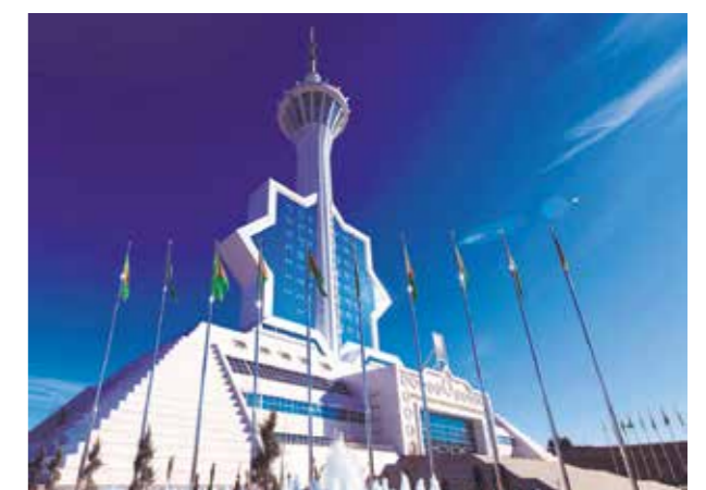
Proje İsmi : Tv Tower Şehir : Aşgabat, Türkmenistan Yatırımcı : Polimeks İnşaat Tarih : 2011
