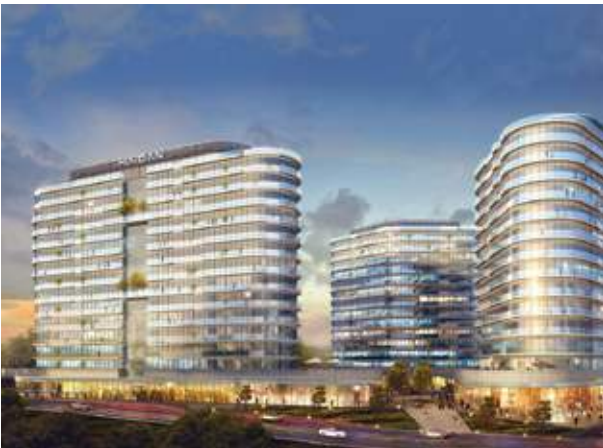
Proje İsmi : Maidan Residence Şehir : Ankara Yatırımcı : Ege Grup Yapı Endüstrisi A.Ş., BM Mühendislik ve İnşaat A.Ş. Tarih : 2016
