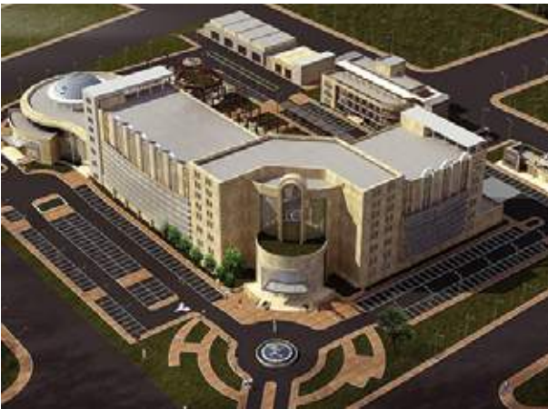
Proje İsmi : Rania 290 Yataklı Devlet Hastanesi Şehir : Süleymaniye, Kuzey Irak Yatırımcı : Kur İnşaat, İntaş İnşaat, Miran İnşaat Tarih : 2015
